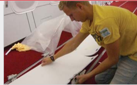
Vartan Mitarbeiter bei der Demontage von Hatrack-Klappen
